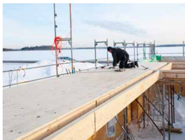
STEICO LVL X jako ztužující deska ve stropní konstrukci.
