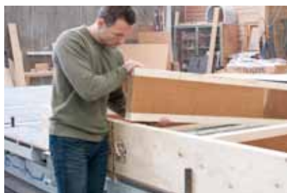
Konstrukční výrobky STEICO při prefabrikaci stěnových modulů
